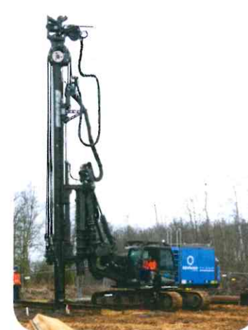
"Mäkler" bei der Arbeit - rechts die Elemente für die Spundwände
